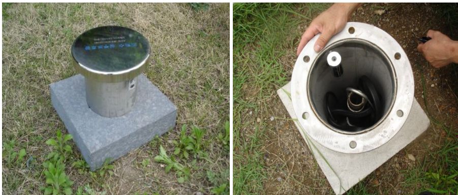
그림 2.2 유형별 상부보호공 설치 사례
